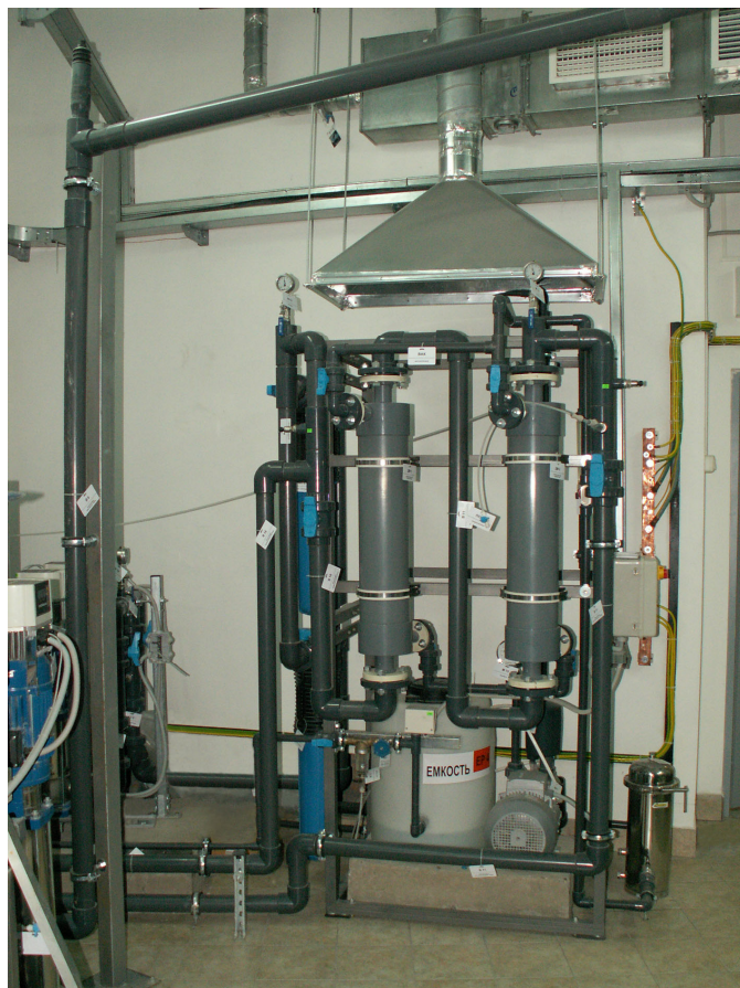
リキセル®脱気装置は、クリスタルな透明感のある氷を造るためにスケートリンクで使用されています。
